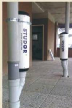
Installazione di una decina di Attenuatori di Pressione Positiva d'Aria presso The HUB Hotel di Milano****
