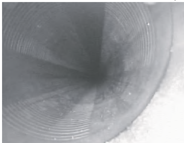
RIVESTIMENTO CON ECOPOZZO DOPO 5 ANNI DALL'INSTALLAZIONE
